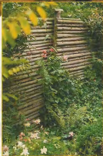
Опорная стенка из жердей.
