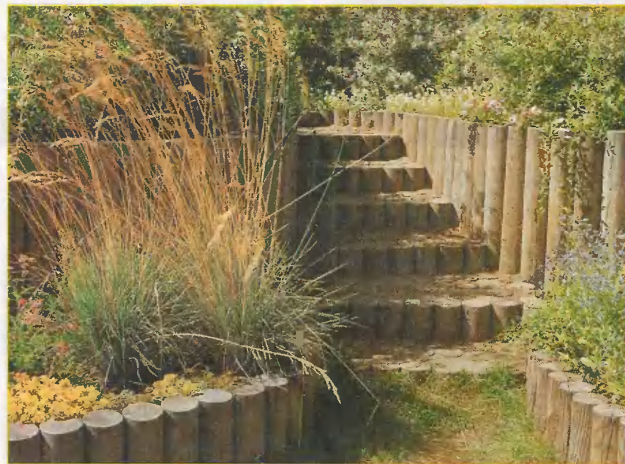
Удивительно красивая лестница в саду. Как ступени лестницы, так и подпорная стенка сделаны из кольев.
