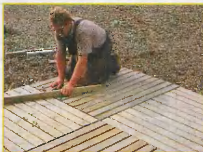
Деревянная площадка в саду, обустроенная собственными силами.
