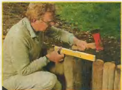
Укрепление склона для подъездного пути к гаражу.
